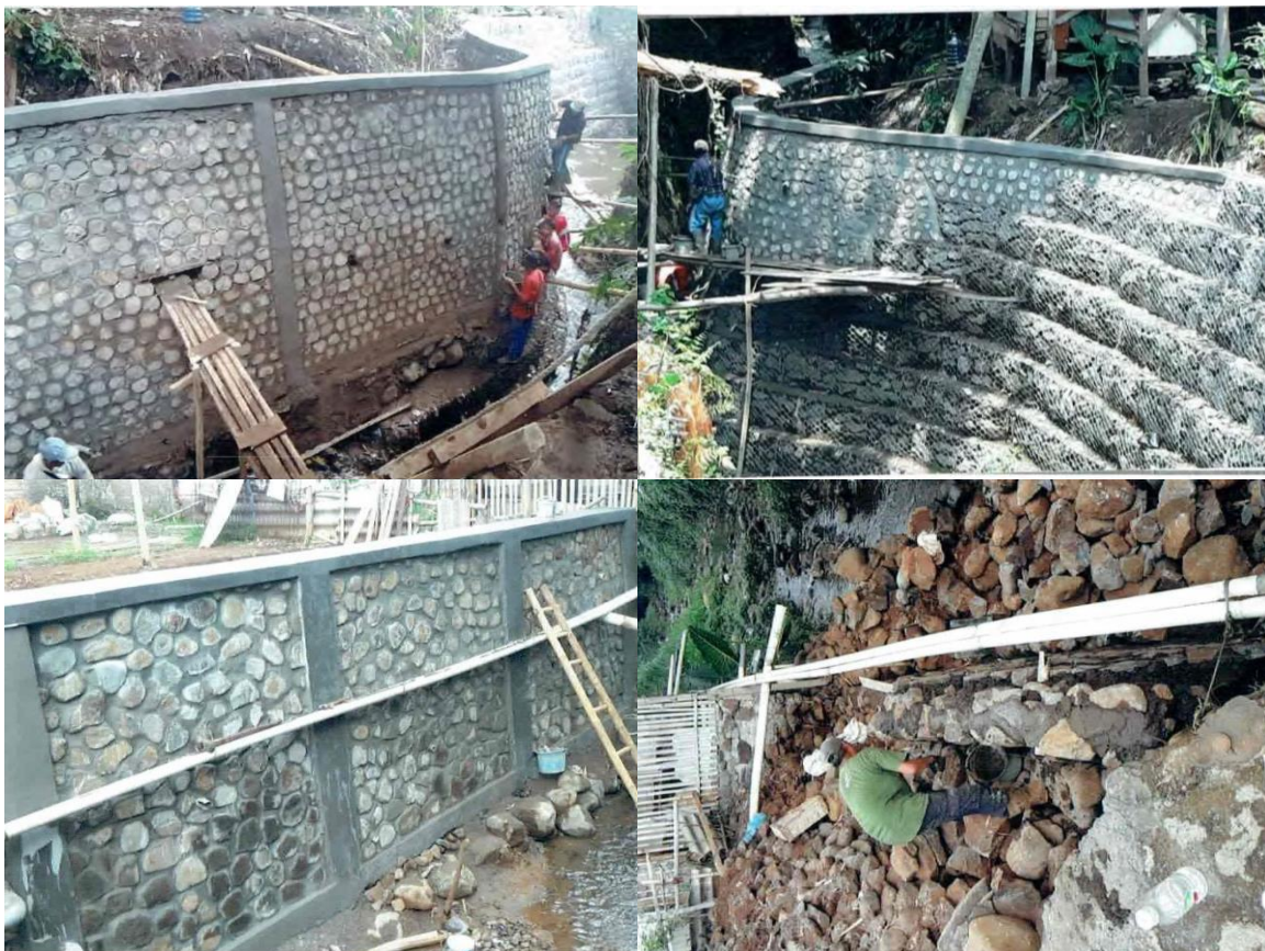
Gambar 3.4 Dokumentasi pekerjaan lingkup Drainase dan Sumber Daya Air Tahun 2019.
