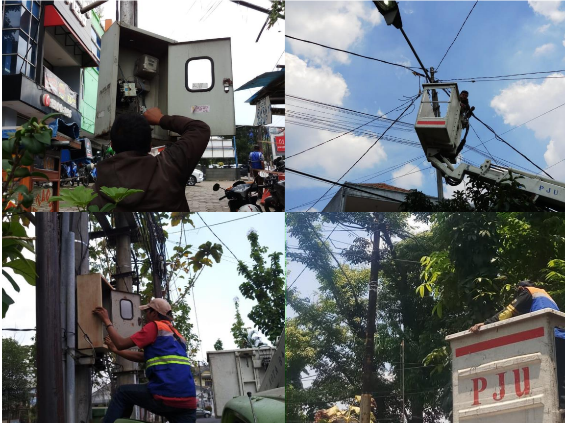
Gambar 3.5 Dokumentasi pekerjaan lingkup Penerangan Jalan Umum Tahun 2019.
