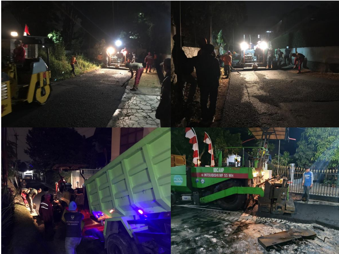
Gambar 3.1 Dokumentasi pekerjaan ligkup Jalan dan Jembatan Tahun 2019.
