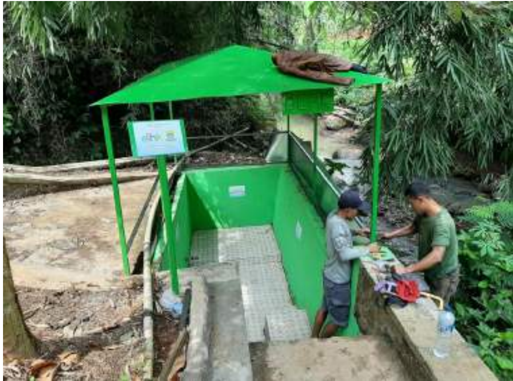
Gambar 3.14 Penataan Mata Air Ciputri
