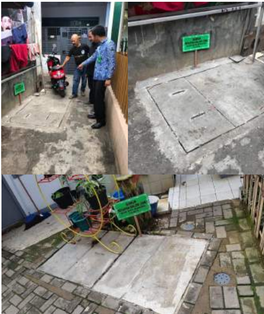
Gambar 3.21 Kegiatan Pemantauan Pembangunan Sumur Resapan Dalam 20 m
