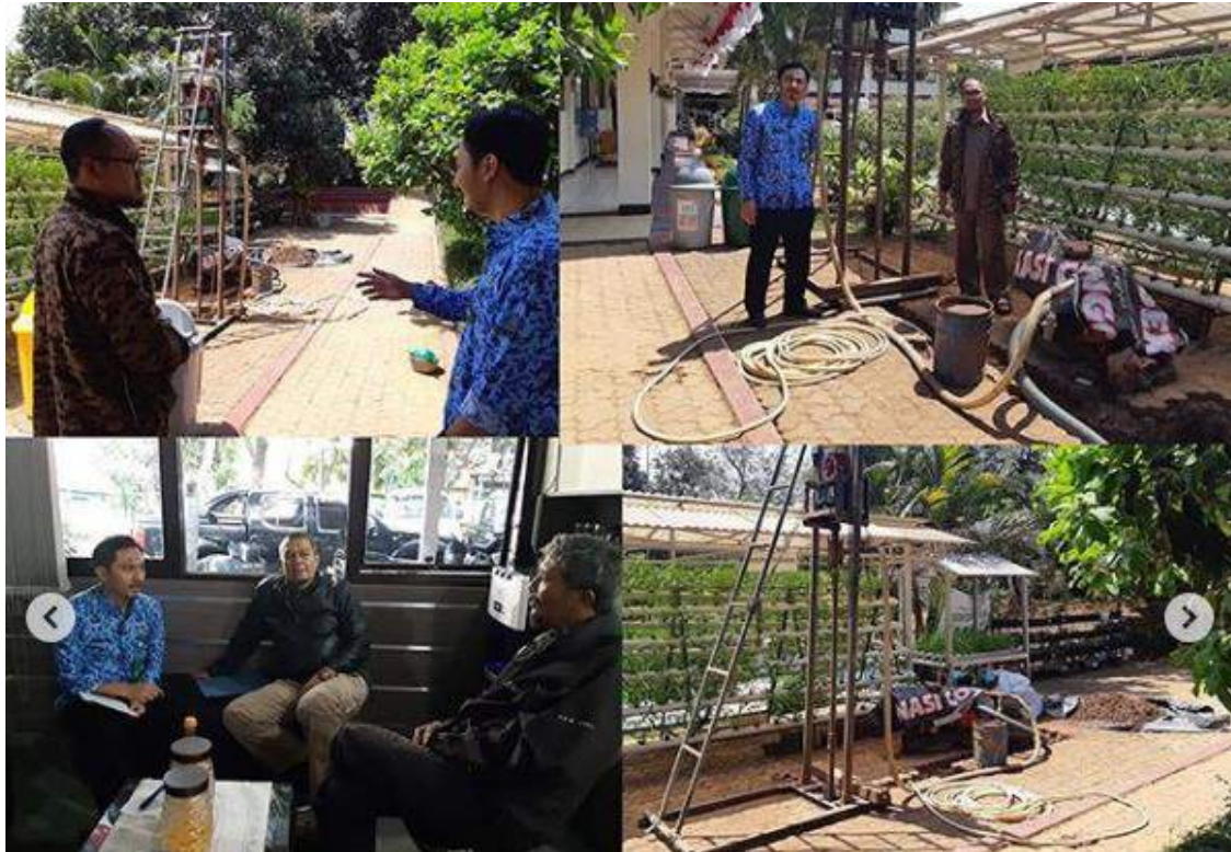
Gambar 3.24 Monitoring pembangunan sumur resapan
