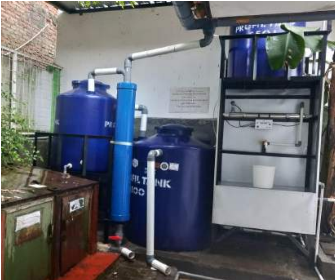
Gambar 3.11 Percontohan Instalasi Rain Water Harvesting (RWH) yang sudah dilengkapi dengan fasilitas pemurnian hingga menjadi air siap minum
