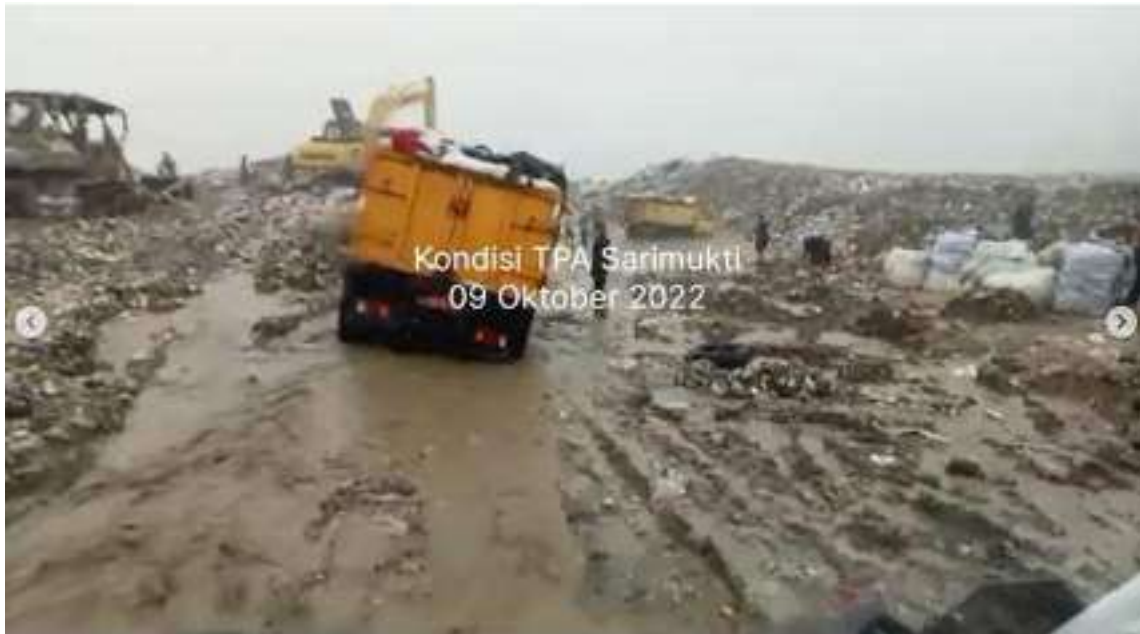
Gambar 3.17 Akses jalan tergenang air hujan di TPA Sarimukti
